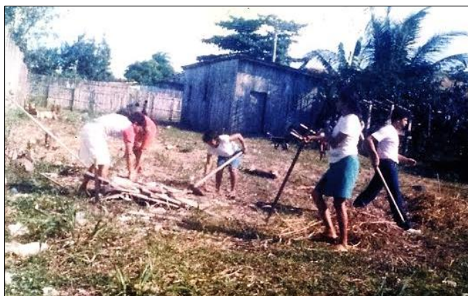
Figura 69 - Moradores da Terra Firme aterrando a área do Centro Comunitário Bom Jesus para horta comunitária.
